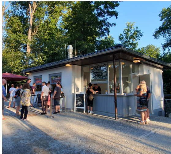
Neues Cateringgebäude an der Freilichtbühne.
