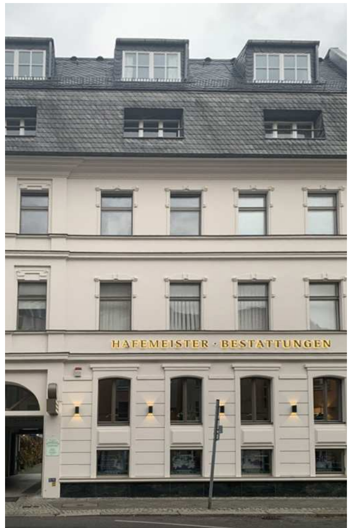
Sanierte Fassade in der Breite Straße 66
